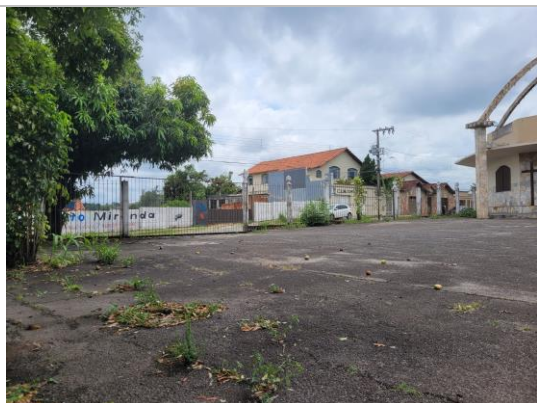
Figura 15: Vista da via e edificações do entorno.
