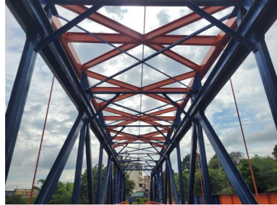
Figura 08: Vista da estrutura superior do Pontilhão. Autoria: Dalva Cristina de Sousa. Data: 20/11/2023.
