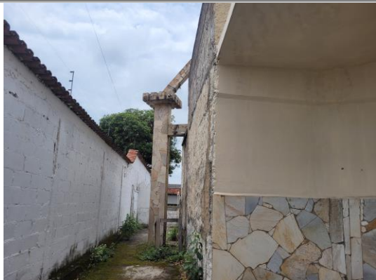
Figura 05: Detalhes da estrutura de um dos arcos na porção posterior. Autoria: Dalva Cristina de Sousa. Data: 20/11/2023.
