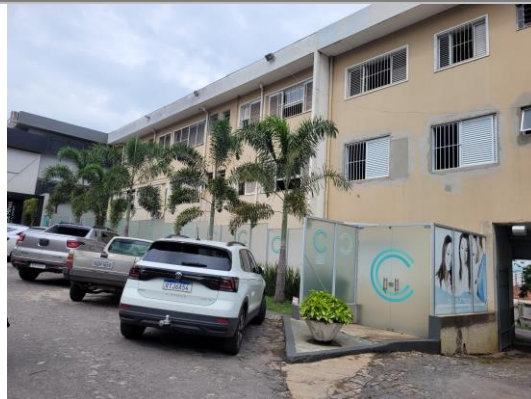
Figura 06: Vista geral da fachada de um dos blocos com intervenções nas esquadrias. Autoria: Dalva Cristina de Sousa. Data: 20/11/2023.
