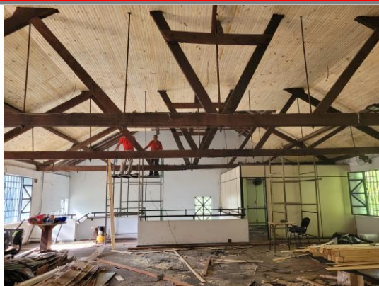
Figura 11: Vista geral do pavimento superior e das estruturas do telhado.
