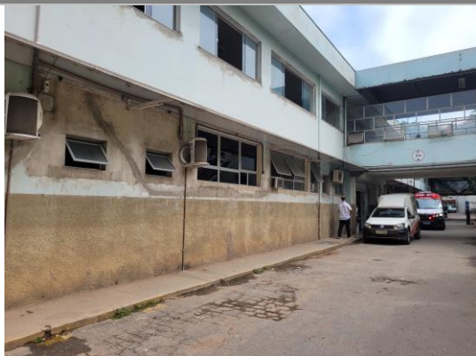
Figura 11: Vista da estrutura mais antiga e via de acesso ao pronto socorro.
