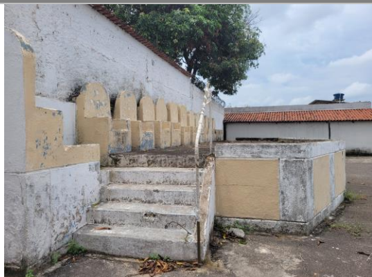
Figura 13: Vista da escada de acesso ao pátio.
