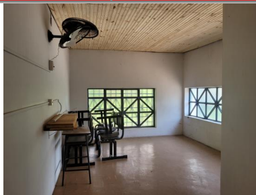
Figura 12: Vista geral de uma das salas no pavimento superior.
