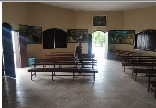
Foto 10: Vista da nave e portas de acesso.
