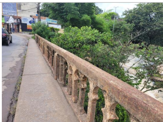
Figura 11: Vista do passeio ao lado do guarda-corpo.
