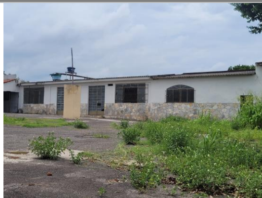
Figura 14: Vista do galpão onde são realizadas reuniões e confraternizações.
