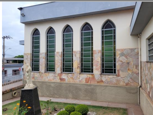
Figura 06: Detalhes das esquadrias da capela. Autoria: Dalva Cristina de Sousa. Data: 20/11/2023.
