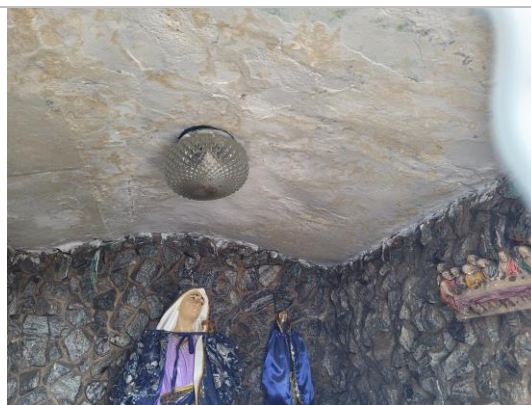
Figura 12: Vista da laje. Autoria: Dalva Cristina de Sousa. Data: 20/11/2023.
