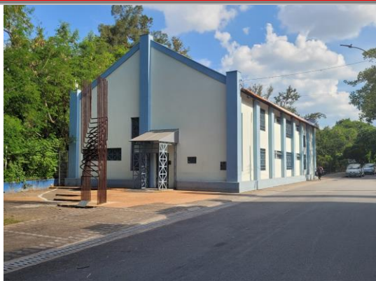
Figura 05: Vista geral da antiga edificação. Autoria: Dalva Cristina de Sousa. Data: 20/11/2023.
