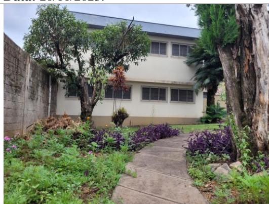
Figura 08: Vista geral do jardim e estrutura da edificação. Autoria: Dalva Cristina de Sousa. Data: 20/11/2023.
