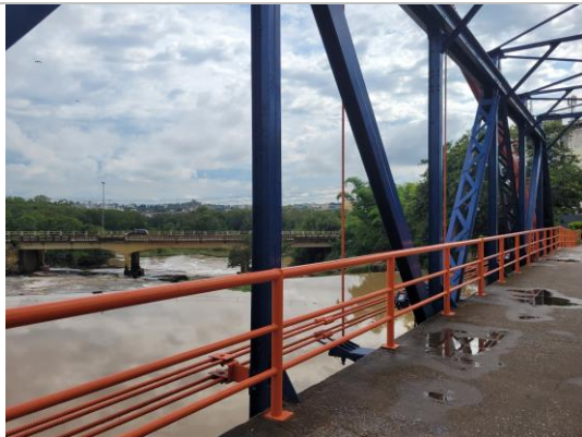
Foto 09: Detalhes do guarda-corpo do Pontilhão. Autoria: Dalva Cristina de Sousa. Data: 20/11/2023.
