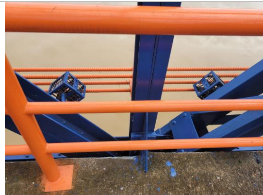
Foto 10: Detalhes da iluminação direcional fixada na estrutura externa do Pontilhão. Autoria: Dalva Cristina de Sousa. Data: 20/11/2023.
