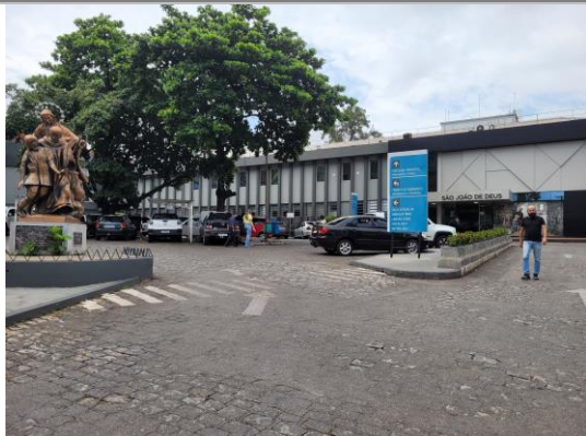
Figura 05: Vista geral da estrutura do Complexo de Saúde e do estacionamento. Autoria: Dalva Cristina de Sousa. Data: 20/11/2023.
