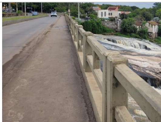
Foto 10: Detalhes do guarda-corpo com características diferentes do original.
