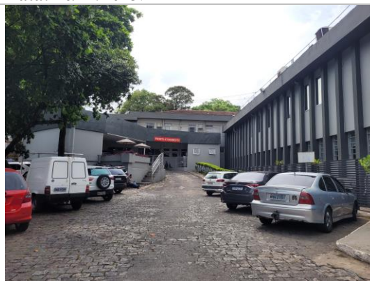
Figura 08: Vista geral das fachadas com várias intervenções. Autoria: Dalva Cristina de Sousa. Data: 20/11/2023.
