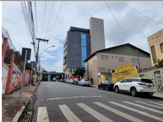
Figura 13: Vista da via e edificações do entorno. Autoria: Dalva Cristina de Sousa. Data: 20/11/2023.
