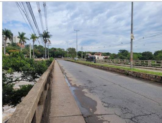
Figura 14: Vista do passeio em cimento e da pavimentação asfáltica.
