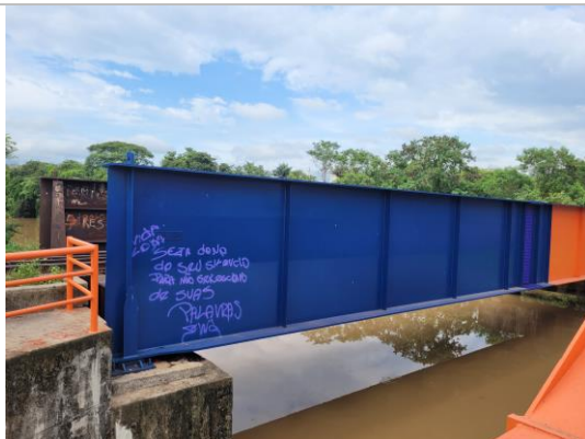
Figura 11: Vista do pontilhão que está ativo atualmente ao lado da estrutura original. Autoria: Dalva Cristina de Sousa.
