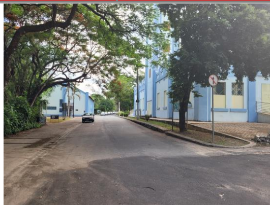
Figura 14: Vista geral do conjunto arquitetônico industrial.
